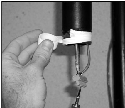
Foto 5F Aplicación de cinta de teflón al tubo
